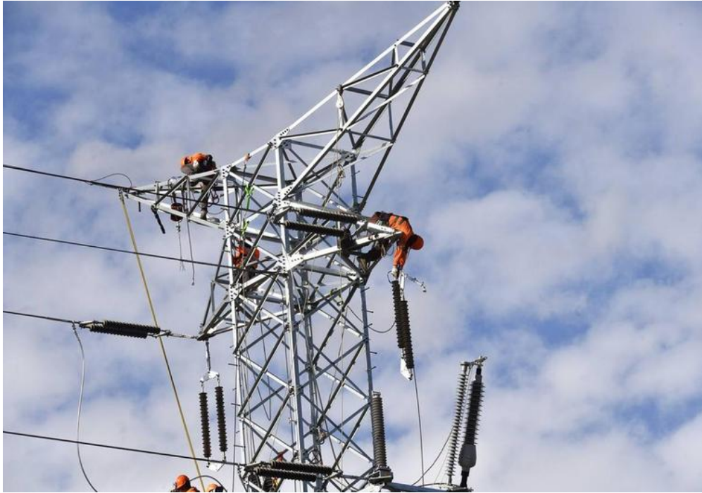
Operarios de Iberdrola trabajan en una de las torres de Los Rectores. Guillermo Carrión/ AGM
